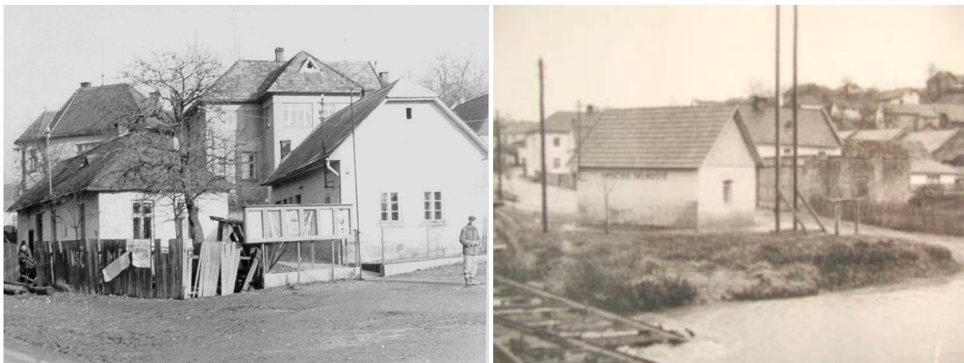
Na levém snímku domky v severní hraně návsi v padesátých letech. Obecní úřadovna č. p. 55 je nižší domek vlevo. Na pravé fotografii je sklad hasičský z jižního konce návsi u řeky. Fotografie je ze čtyřicátých let. Zdroj www.luzkovice.cz
