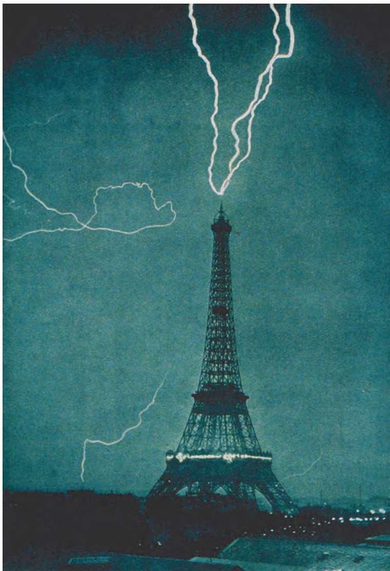
Obr. 1. Fotografie Eiffelovy věže v Paříži ze dne 3. 6. 1902 ve 21:20. Patrný je opačně orientovaný blesk typický pro výškové budovy.
