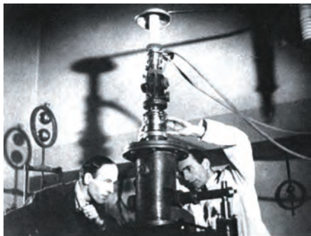
Knoll (nalevo) a Ruska (napravo) při stavbě elektronového mikroskopu v roce 1932. Dobová fotografie.
