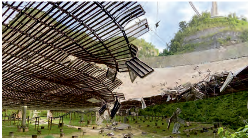
Arecibo po prasknutí nosného lana. Zdroj: NSF.
