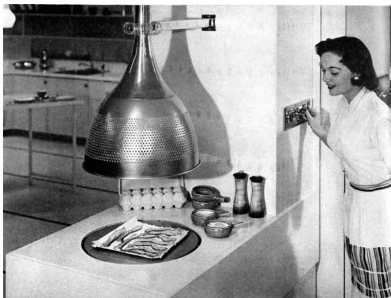
Jedna z variant mikrovlnné trouby z roku 1959. Zdroj vlnění je pod pečicí deskou. Horní děrovaný zvon je kryt, který brání mikrovlnám v průniku ven. Mikrovlnný zdroj lze zapnout jedině tehdy, když je zvon spuštěn a zcela kryje prostor s ohříváním jídlem. Zdroj: Sogou.
