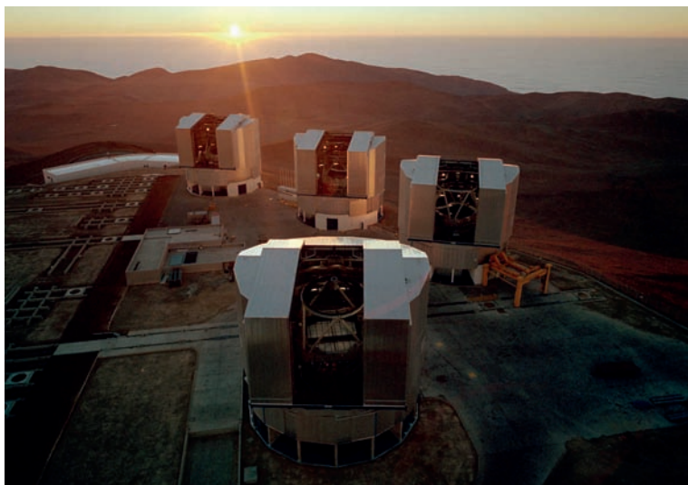
Obr. 24. Velmi velký dalekohled (VLT) je čtveřice dalekohledů o průměrech 8,2 metru, která je umístěna na hoře Cerro Paranal v Atakamské poušti v Chile. Dalekohledy mají aktivní i adaptivní optiku a patří Evropské jižní observatoři (ESO). Zdroj: ESO.
